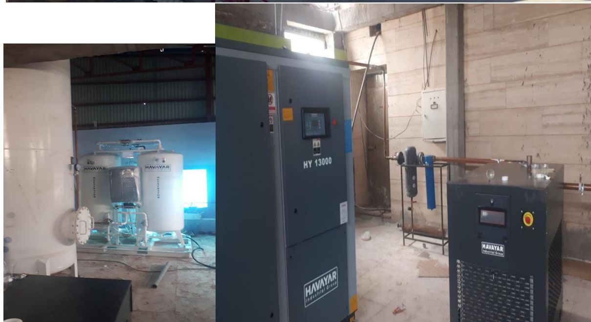
احداث محل و نصب دستگاه اکسیژن ساز
