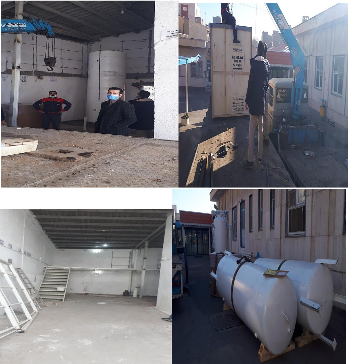
نصب دستگاه اکسیژن ساز بیمارستان شهید دکتر بهشتی با ظرفیت ۶۰۰ لیتر
