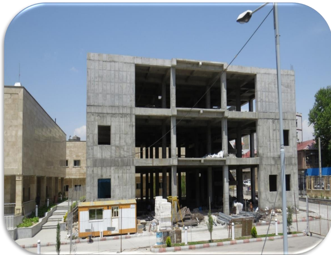
احداث والحاق ، ساختمانهای جنبی درمانی ومحوطه سازی مرکز آموزشی درمانی سینا
